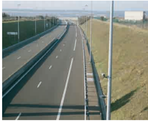
Section d'autoroute en déblai
