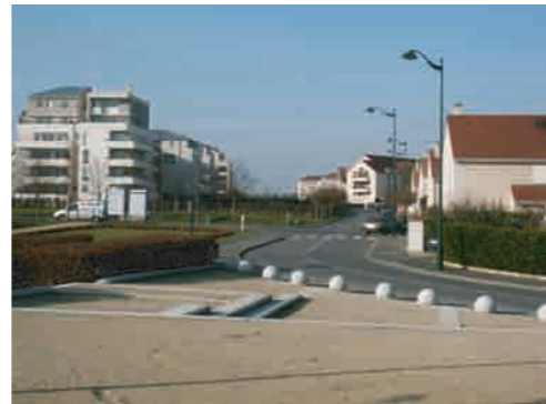
Aménagement d'une tranchée couverte en milieu urbain
