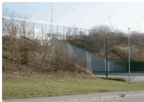
Remblais avec protection phoniques
