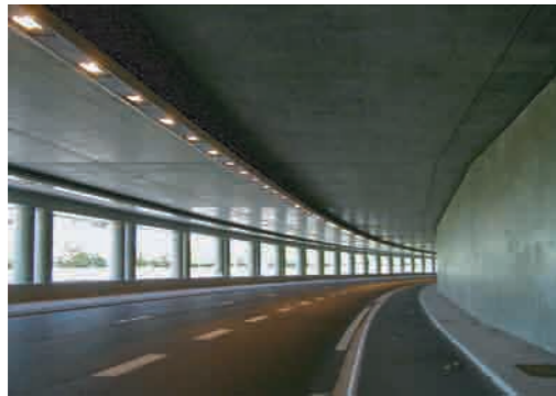
Section d'autoroute semi-couverte
