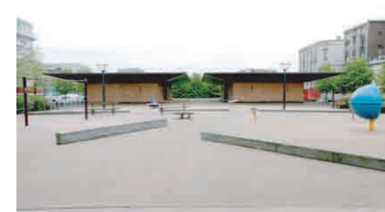
Locaux de ventilation des tunnels
