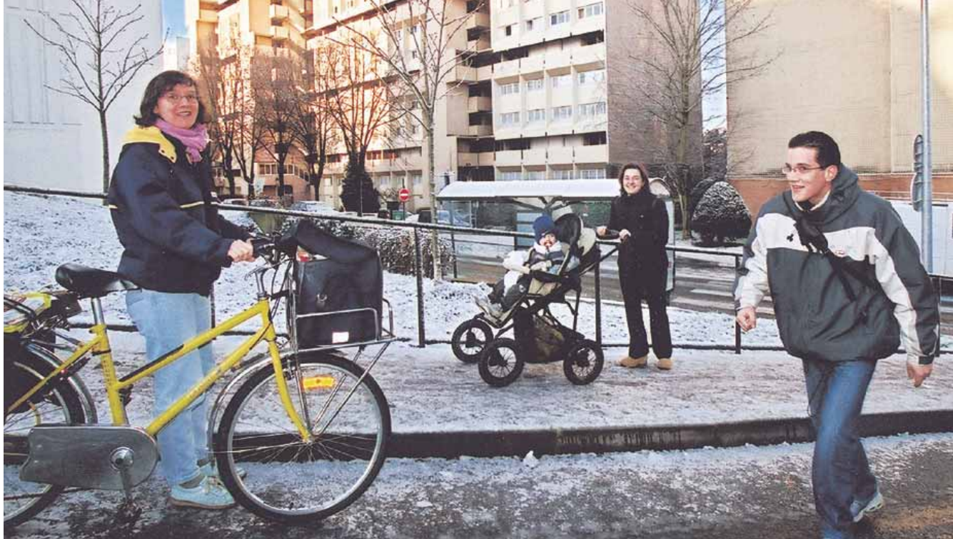
QUARTIER DU BEL AIR Les 469 logements sociaux des 3F sont en cours de réhabilitation.
