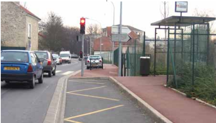
QUARTIER SAINT-LÉGER Rénovation de la voirie rue Saint-Léger.
